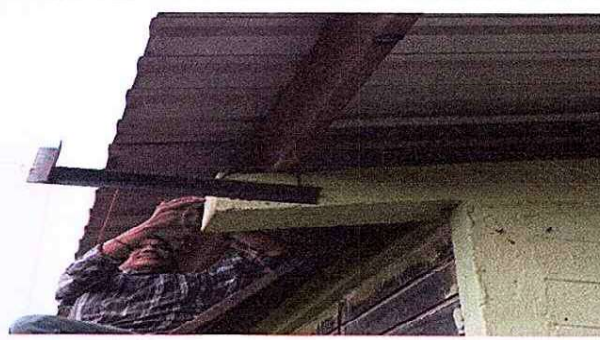
Se observa el cambio de los canales de bajadas de agua pluvial.
