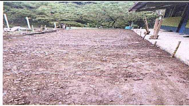
Se observa la colocacion de piso en corredor
