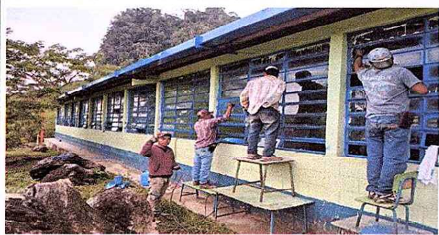
Se observa la colocacion de vidrios de las ventanas de la escuela.
