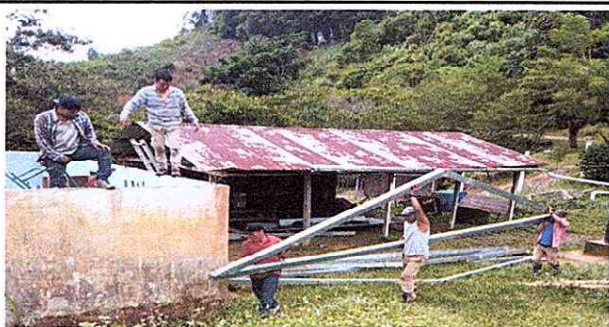
Se observa el cambio de las costaneras de la cocina.
