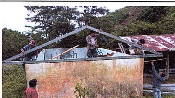
Se observa el cambio de las laminas del techo de la cocina.
